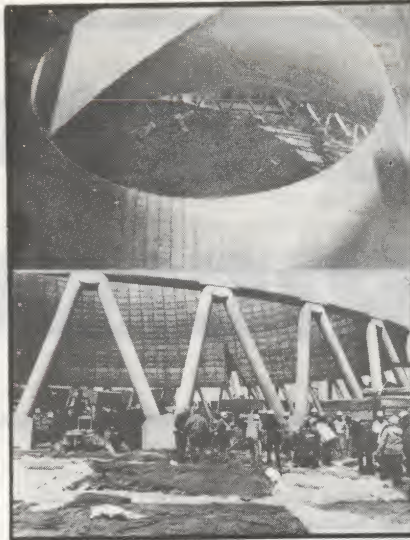
WILLOW ISLAND, WEST VIRGINIA: Na e construccion di un freezer na Willow Island na West Virginia 51 obrero a perde nan bida, ora un stelage 60 meter riba tera a kibra y e obregonan a cai den profundidad. Riba e potret mas abao nos por weita e restunan mortal tapa. Ariba nos por weita e toren den cual e accidente a sosode.
